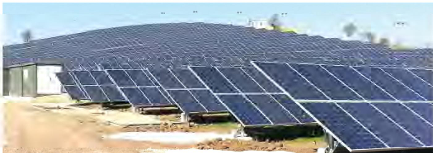
Fotovoltaik Güneş Enerjisi Sektörünün en önemli oyuncusu olan Tekno Ray Solar, Adiyaman - Göleğen'de bulunan 1000 kWp kapasiteli Türkiye'nin MW boyutunda, zemine monte ilk onaylanmış güneş enerji santralini devreye aldı. Bölgenin öncü firması AKM-Kent devreye alınan bu güneş enerji santrali ile yılda 1.562.300 kWh elektrik üretiyor. Solar enerji sektöründe bir ilki gerçekleştiren Tekno Ray Solar, Türkiye'nin çeşitli bölgelerinde yeni santrallerin kurulumuna da devam ediyor.
